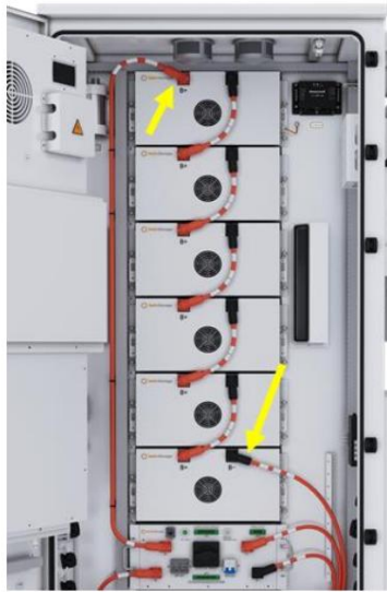
Figure 8-1 Vérifier la connexion du câble
