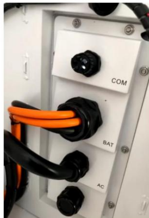
Figure 7-12 Étapes du passage du câble
