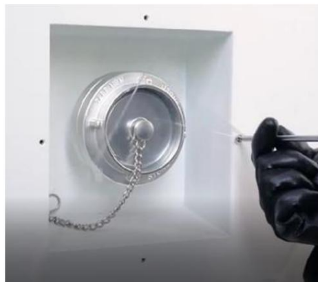
Figure 7-43 Retirez le couvercle de l'entrée d'eau
